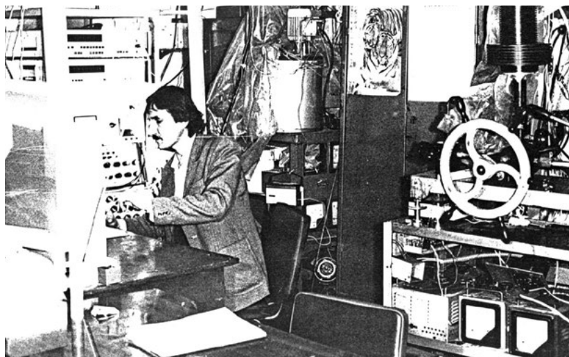
Александр Николаевич Щежин проводит измерения изобарной теплоемкости нефтяных фракций методом проточного адиабатического калориметра
