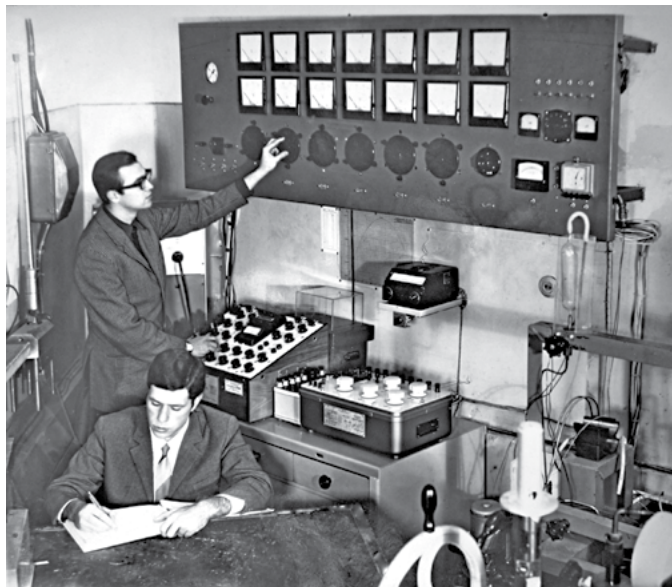
Аспирант В.К. Грачев (стоит) и студент – дипломник М.И. Левинбук исследуют закономерности движение жидкости при переменном перепаде давления на концах капилляра
