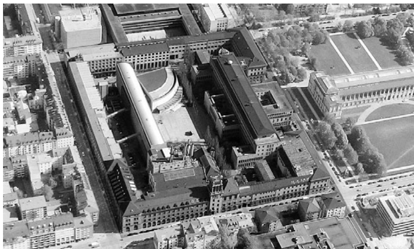
Комплекс зданий Мюнхенского технического университета (TU Munich)
