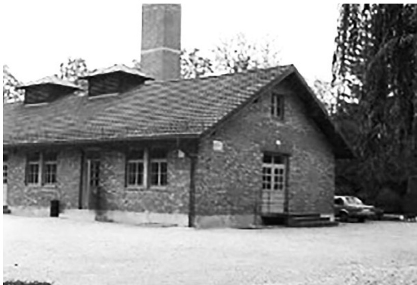
Одноэтажное здание крематория с характерной прямоугольной трубой
