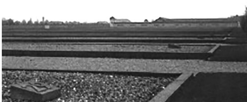
Фундаменты барачков. На переднем плане барак под №29
