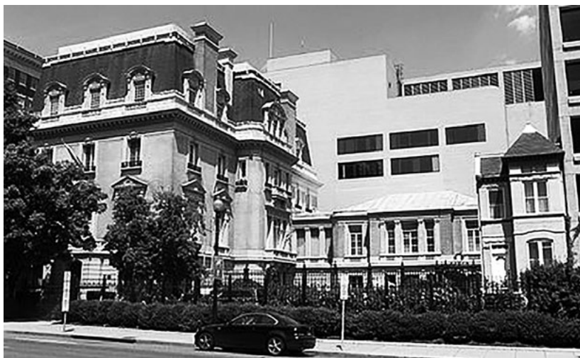
Старое здание посольства СССР в Вашингтоне
